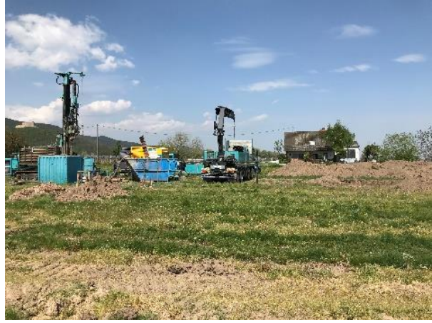
Réalisation de la sonde pilote (Photo : Pflazwerke)
