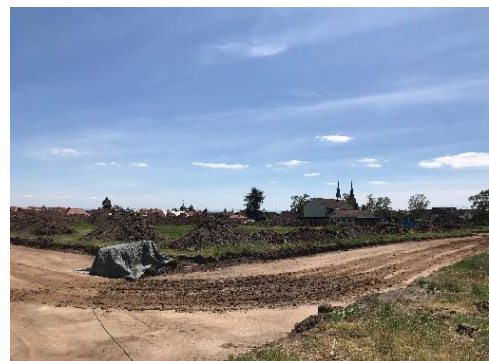
Le test de réponse géothermique dure jusqu'à 72 heures – la photo montre ici l'installation sous la protection contre les intempéries. (Photo : Pflazwerke)
