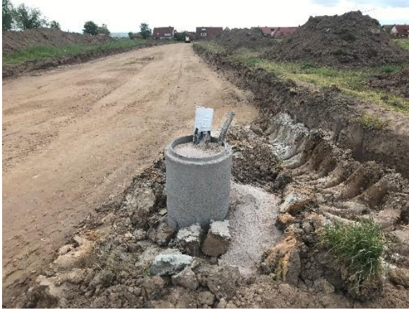
Forage pilote achevé – Celui-ci a lieu au début des travaux (Photo : Pflazwerke)
