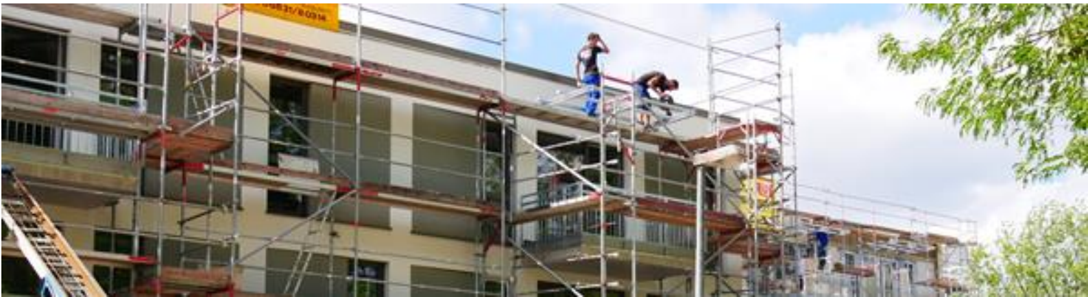
Foto / photo : ARGE Solar
