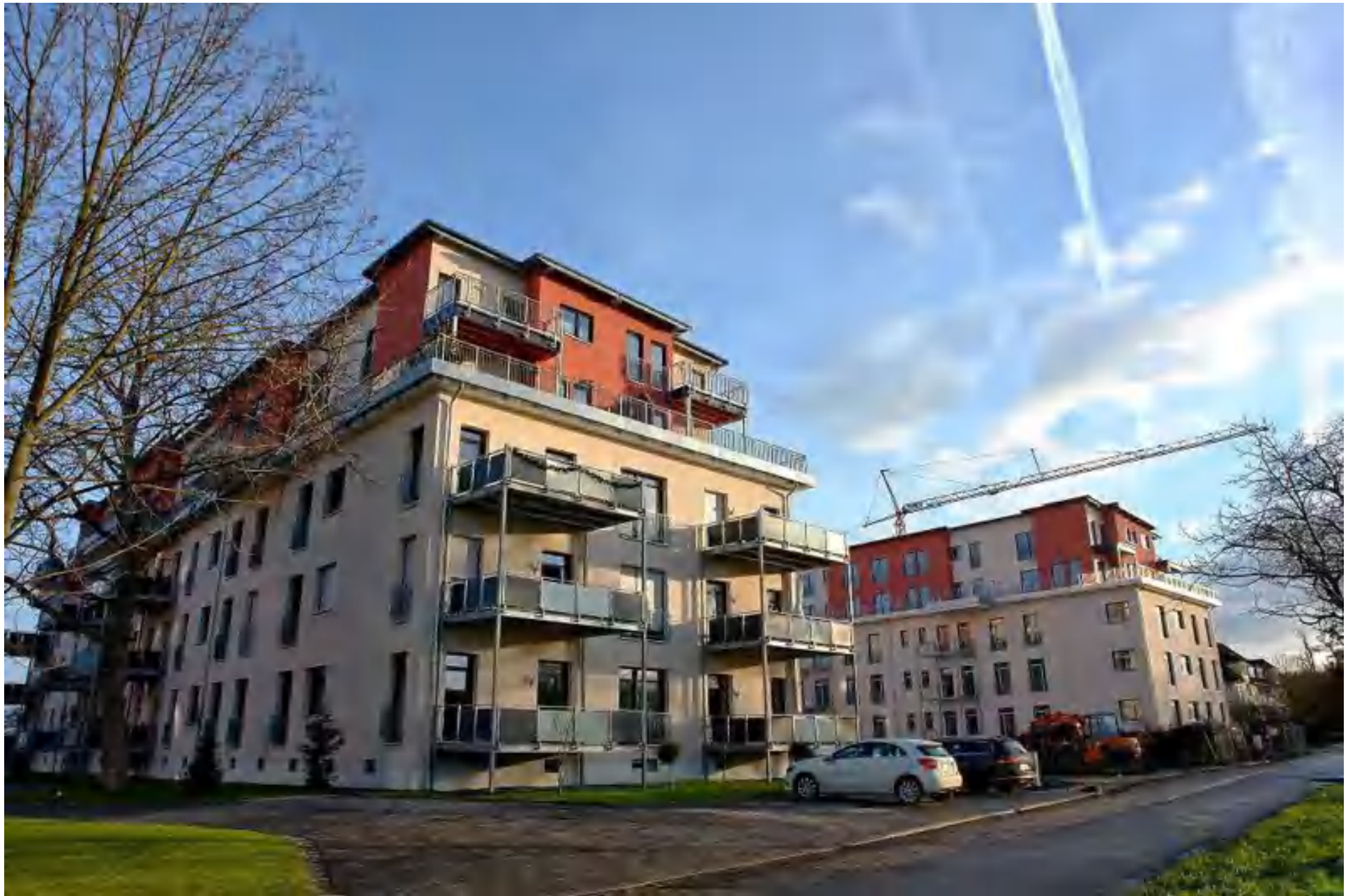
Koblenz, Aufstockung Wohnanlage (2013)
