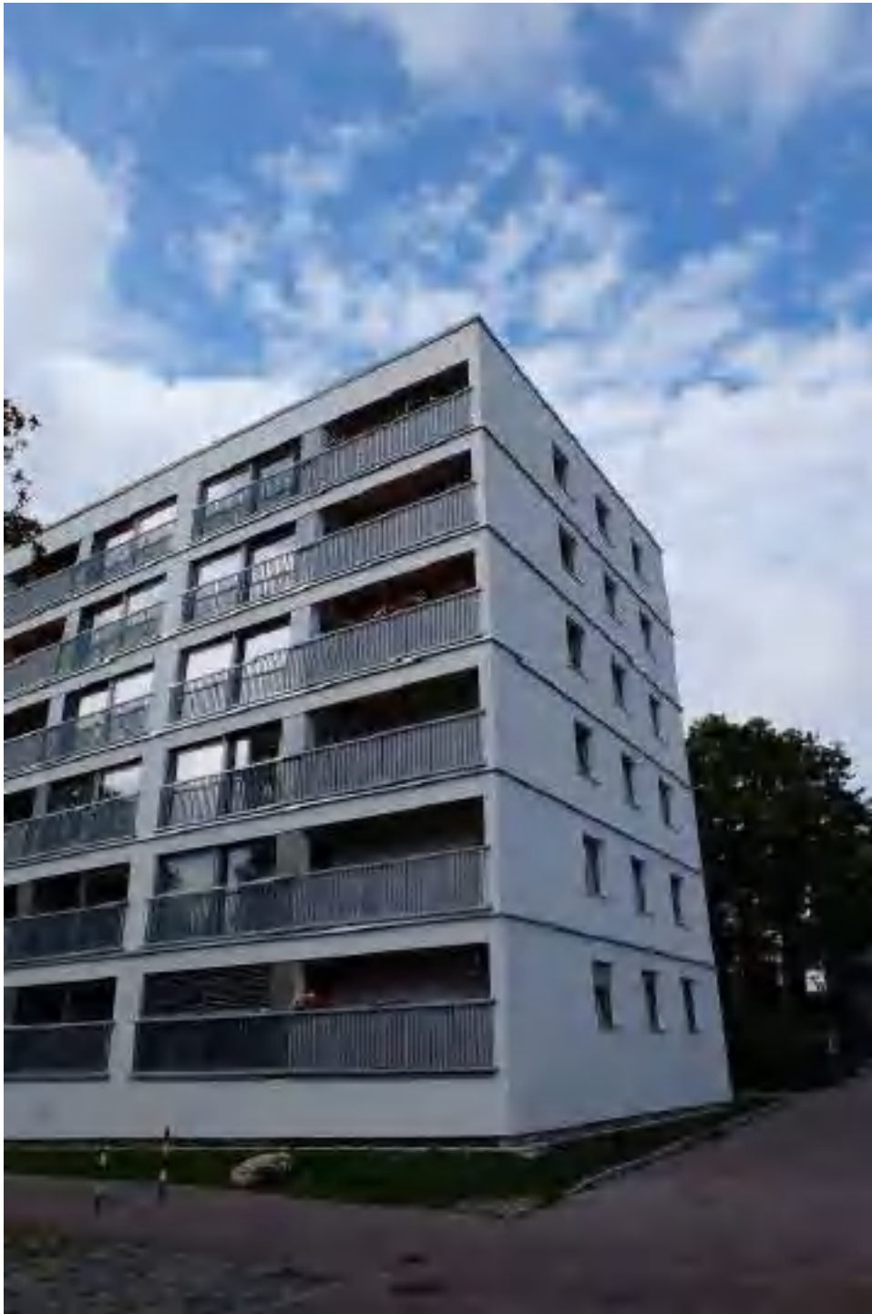
Augsburg, Sanierung Sechsgeschossige Wohnanlage Grüntenstrasse Mit TES Energy Facade (2012)
