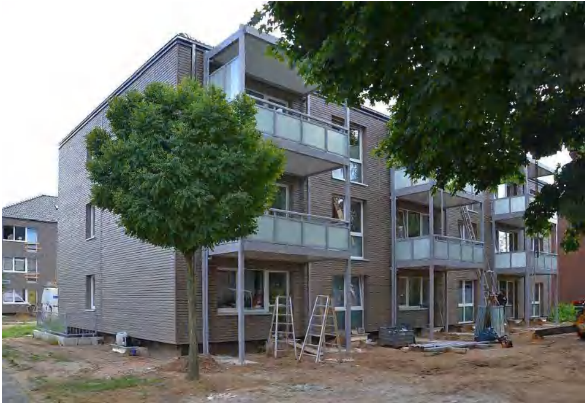
Duisburg, energetische Sanierung Wohnsiedlung (2013) – Photo: Holzbau Kappler
