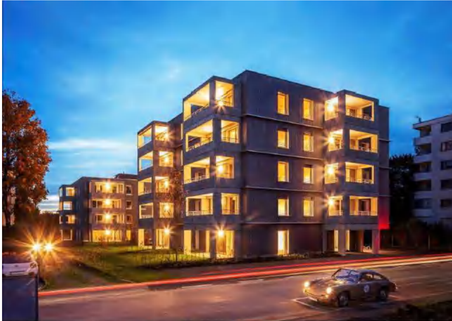
Wolfurt/Vorarlberg. Zwillingsbau Beton/Holz mit Vergleichsstudie https://www.rhomberg.com/de/studienprojekt-lerchenstrasse Gemeinschaftsprojekt Wohnbau-Selbsthilfe und Rhomberg Bau
