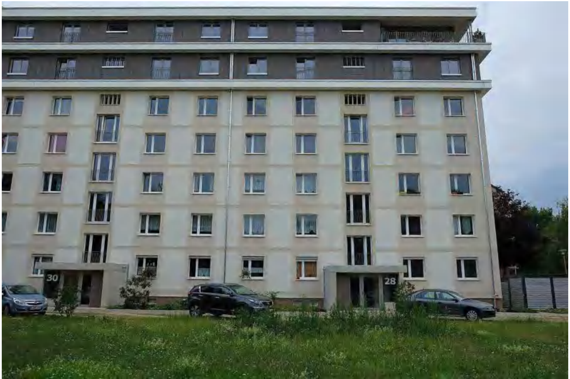
Dresden, Aufstockung Genossenschaftswohnungen Blasewitzer Strasse (2017)
