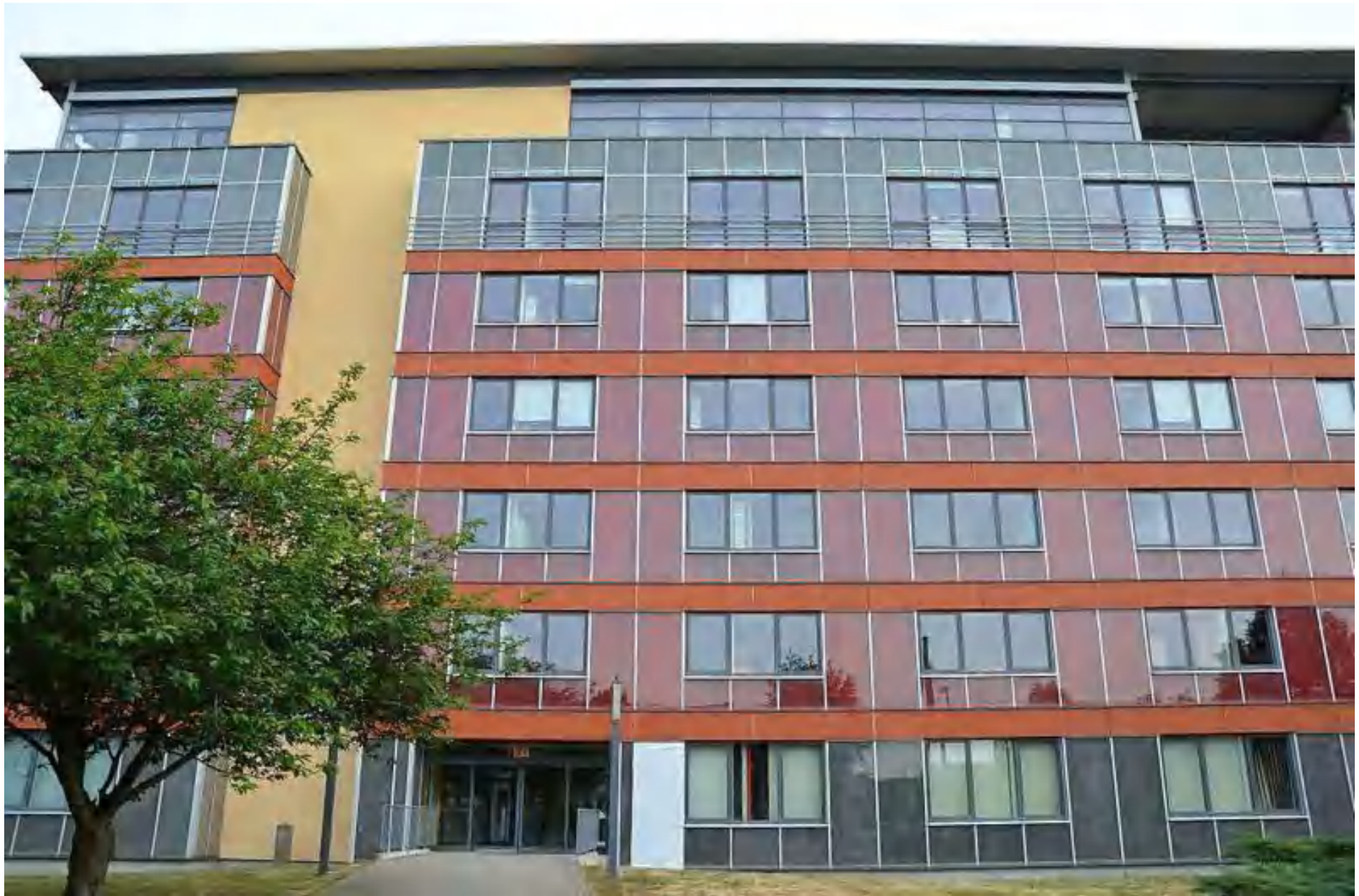
Erfurt, Sanierung Plattenbau (2002)
