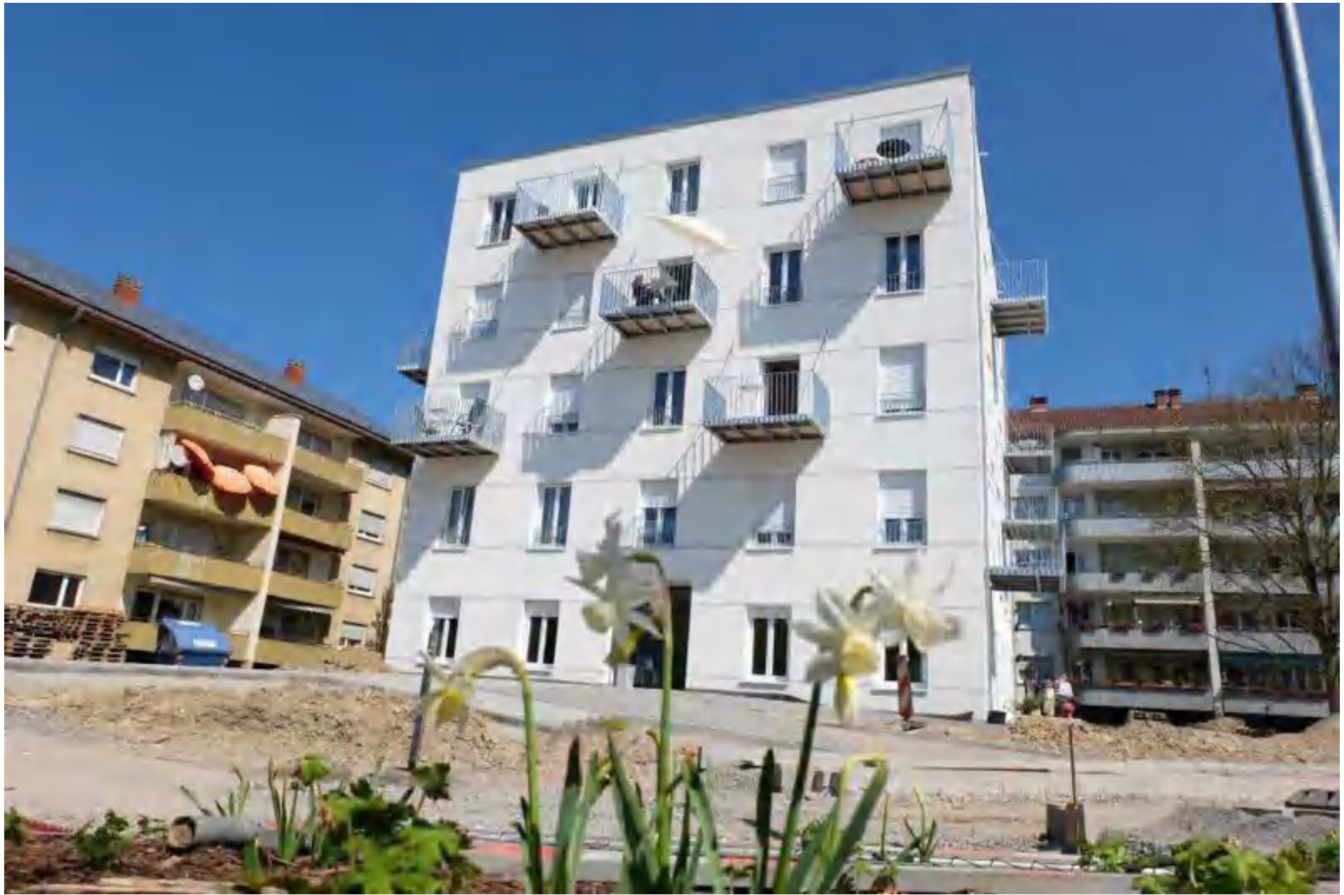
Speyer (2016), Nachverdichtung einer Wohnanlage der GEWO, 4 und 5 Geschosse in BSP
