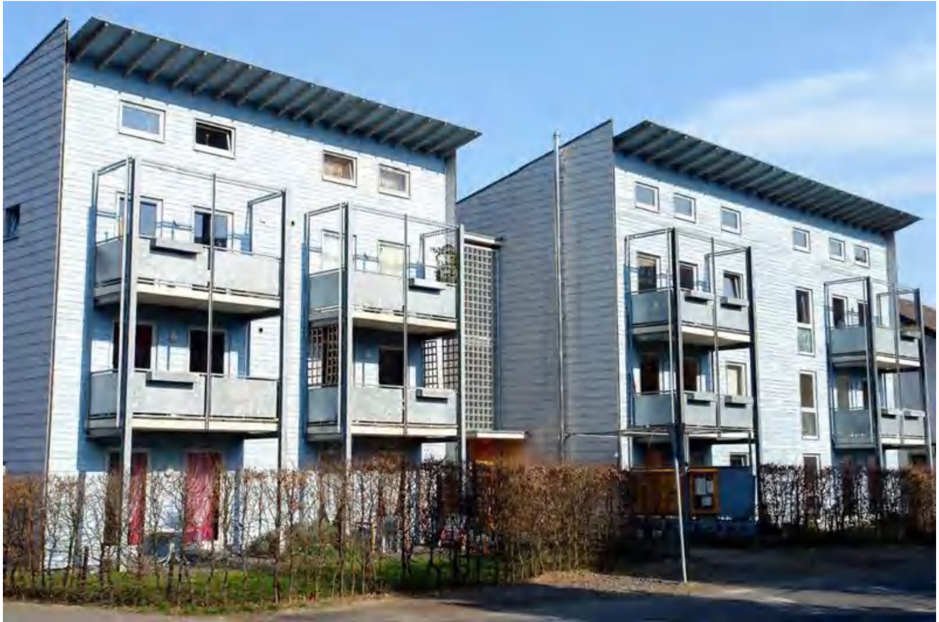
2000 – erster Dreigeschossler in Rheinland-Pfalz nach neuer Landesbauordnung
