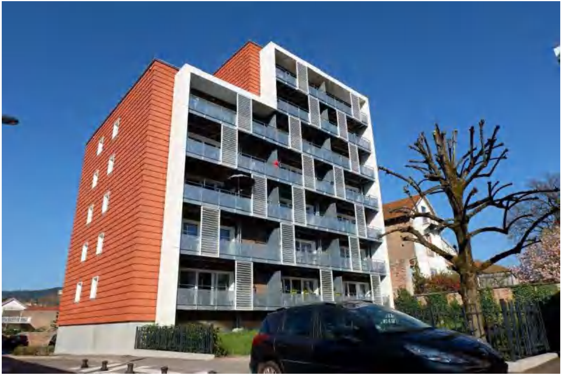
Saint-Dié, Siebengeschosser , Passivhaus mit Strohballendämmung (2013)
