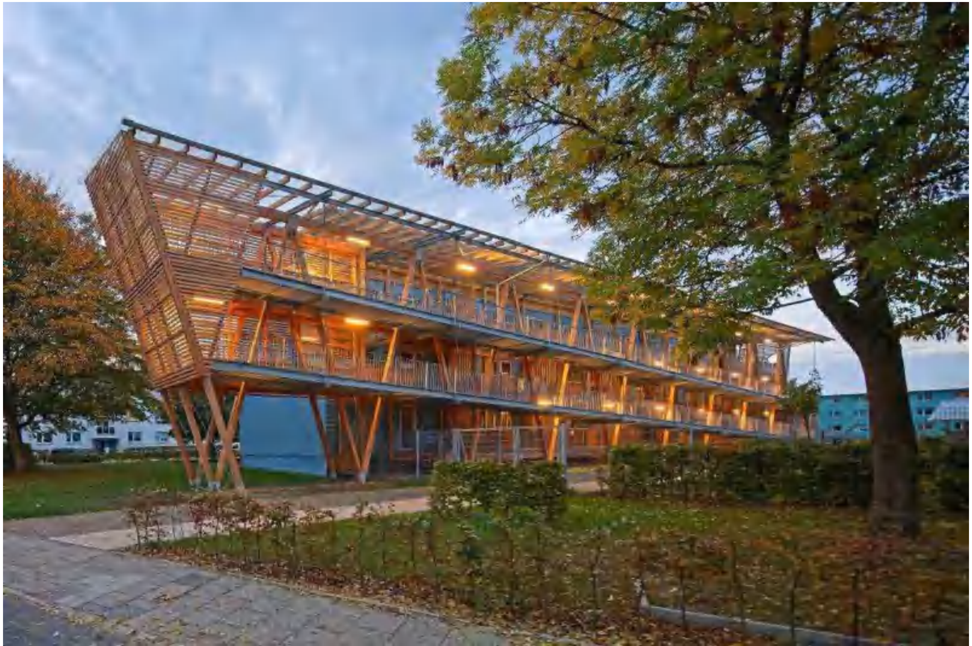
Bremerhaven-Wulsdorf – soziale Stadt: Sanierung von Schlichwohnungen, u.a. barrierefreie Rampe http://www.soziale-stadt-wulsdorf.de/architektur/ Foto: Bernd Perlbach (2017)
