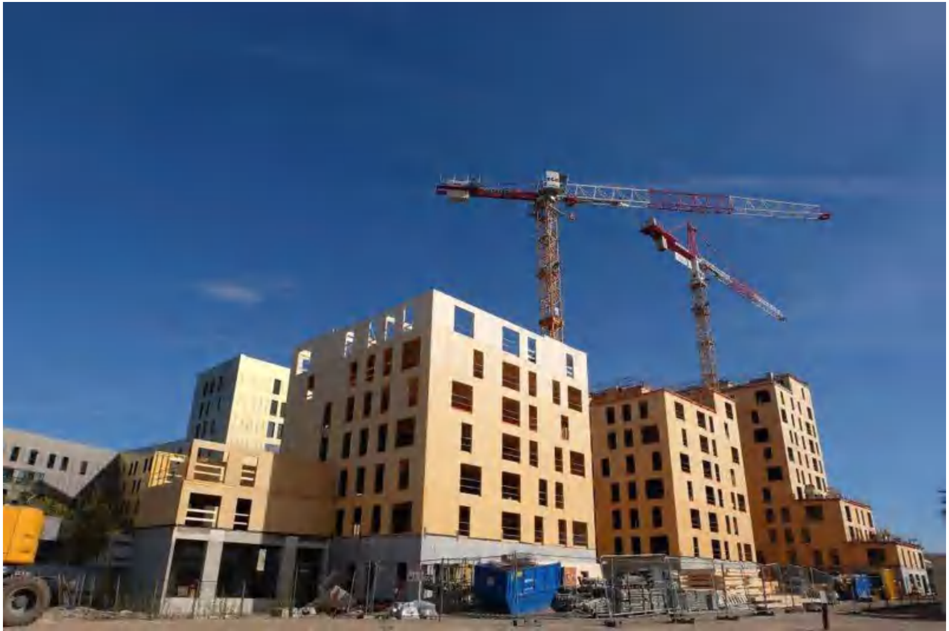
Strasbourg, Ilot Bois – zwölf Geschosse in Massivholzbauweise (2019)
