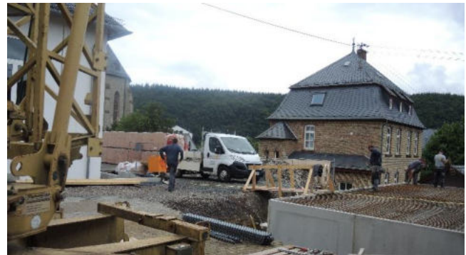
Foto / photo : Energieagentur Rheinland-Pfalz
