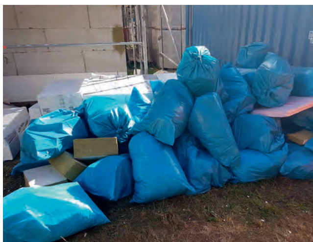
Tri exemplaire des déchets sur le chantier (Photos : ARGE SOLAR)
