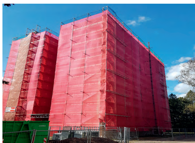
Pour éviter les effets néfastes sur les locataires et l'environnement, les bâtiments ont été complètement encastés pendant les travaux sur les murs extérieurs. (Photo : ARGE SOLAR)
