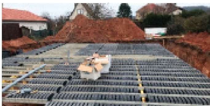
Préparation de la dalle pour recevoir les murs préfabriqués (Photo: Moselis/CDC Habitat Sainte Barbe)
