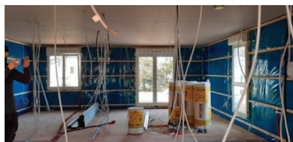
Mise en place des réseaux électriques et de plomberie sanitaire ventilation (Photo: Moselis/CDC Habitat Sainte Barbe)
