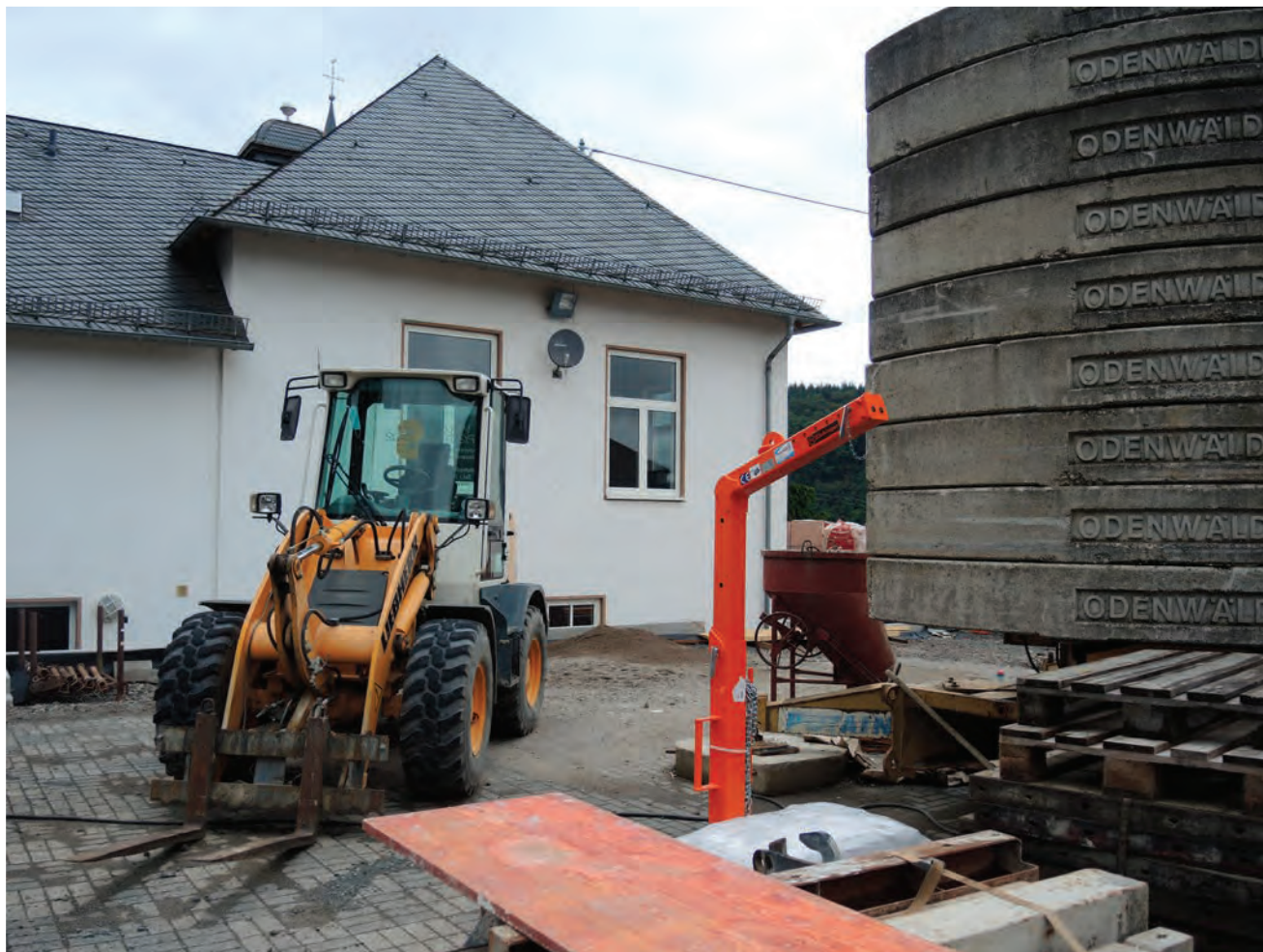
Chantier devant la garderie avec vue sur la maison des associations, qui sera également raccordée au réseau de chaleur local (photo : Energie-agentur Rheinland-Pfalz)
