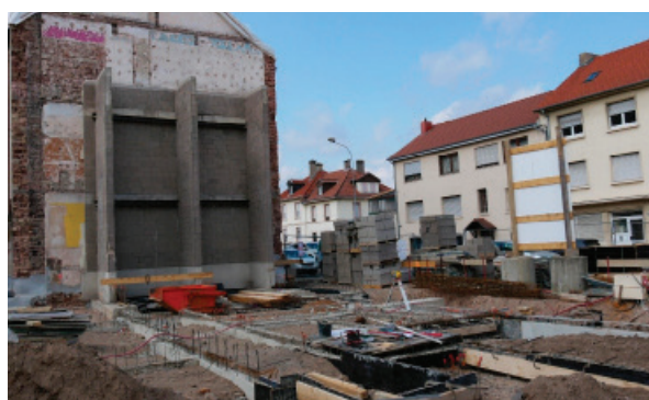
Le chantier en septembre 2020 (Photo: ARGE SOLAR)
