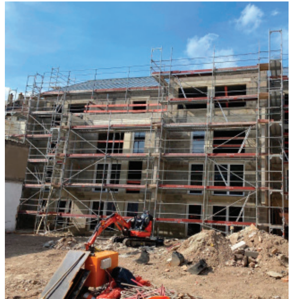
Chantier en cours, Avril 2021 (Photo: Vivest)
