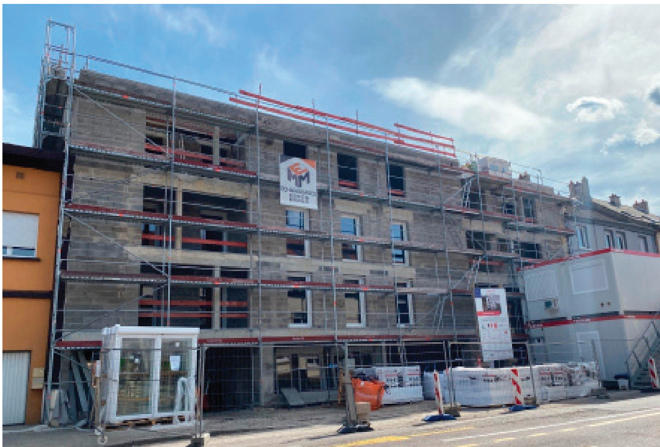
Le chantier en avril 2021 (Photo: Vivest)
