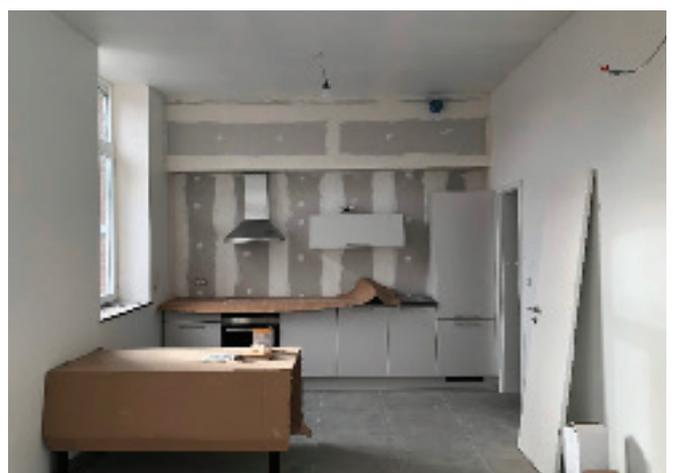
Als erstes wurden die Zimmer im vorderen Teil des Gebäudes renoviert. Hier: Aufbau von Trockenbauwänden und Einbau einer Fußbodenheizung. Heute beherbergen sie u.a. das Koordinationsbüro. (Fotos: CITÉnergie Aubel)
