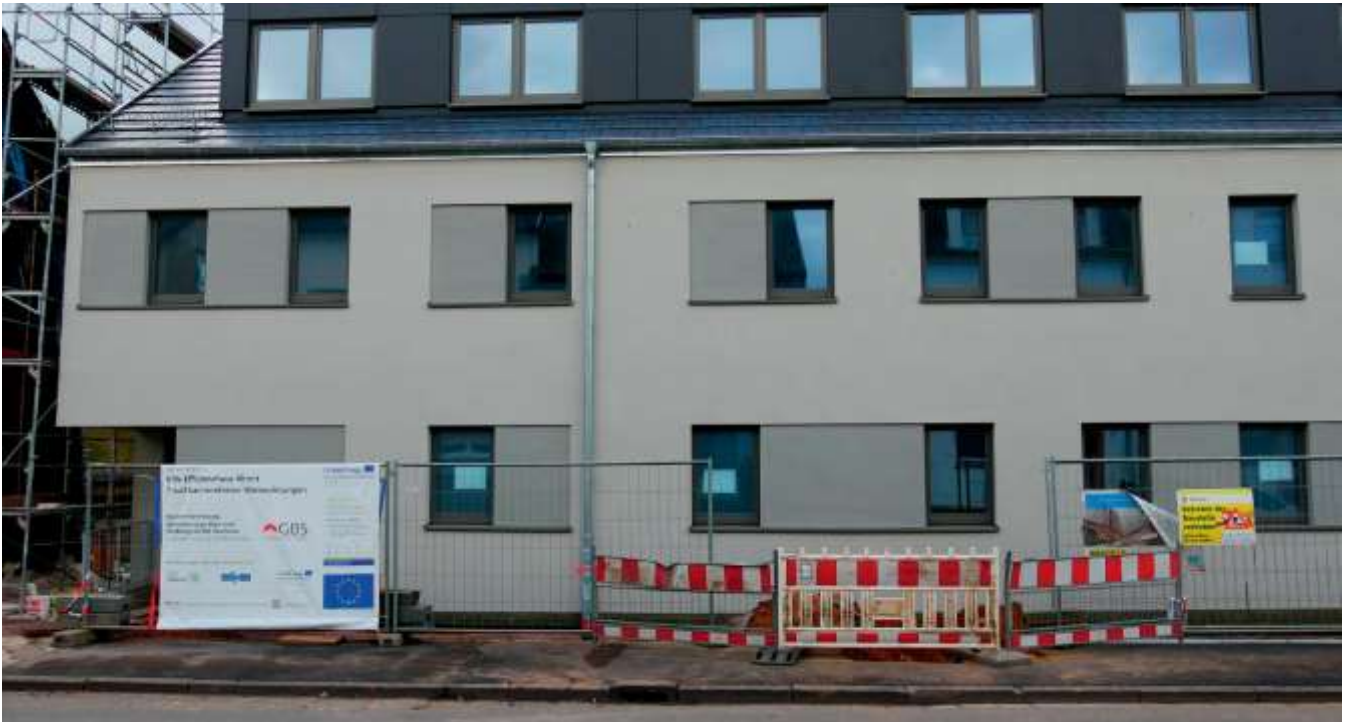
Sozialer, barrierefreier Wohnungsbau in der Herrenstraße 35-37 in Saarouis Roden (Foto: ARGE SOLAR)
