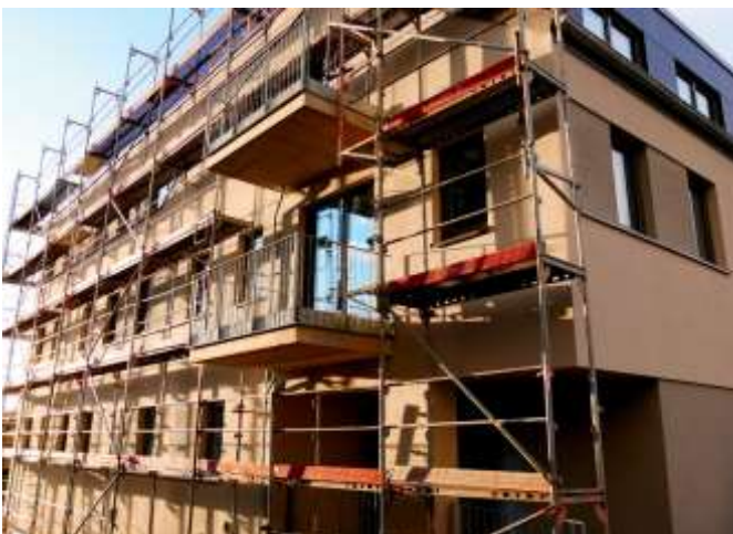
Blick auf den Eingangsbereich kurz vor der Fertigstellung (Foto: ARGE SOLAR)
