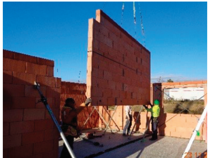
Aus Gründen der Schnelligkeit verwendete der Bauunternehmer Mauern vorgefertigte Terrakottaplatten, die auf der Baustelle mit den tragenden Stürzen hingegen werden von den Architekten in aus Stahlbeton vorgefertigt und auf der Baustelle eingebaut. (Fotos: La Maison des Hommes)
