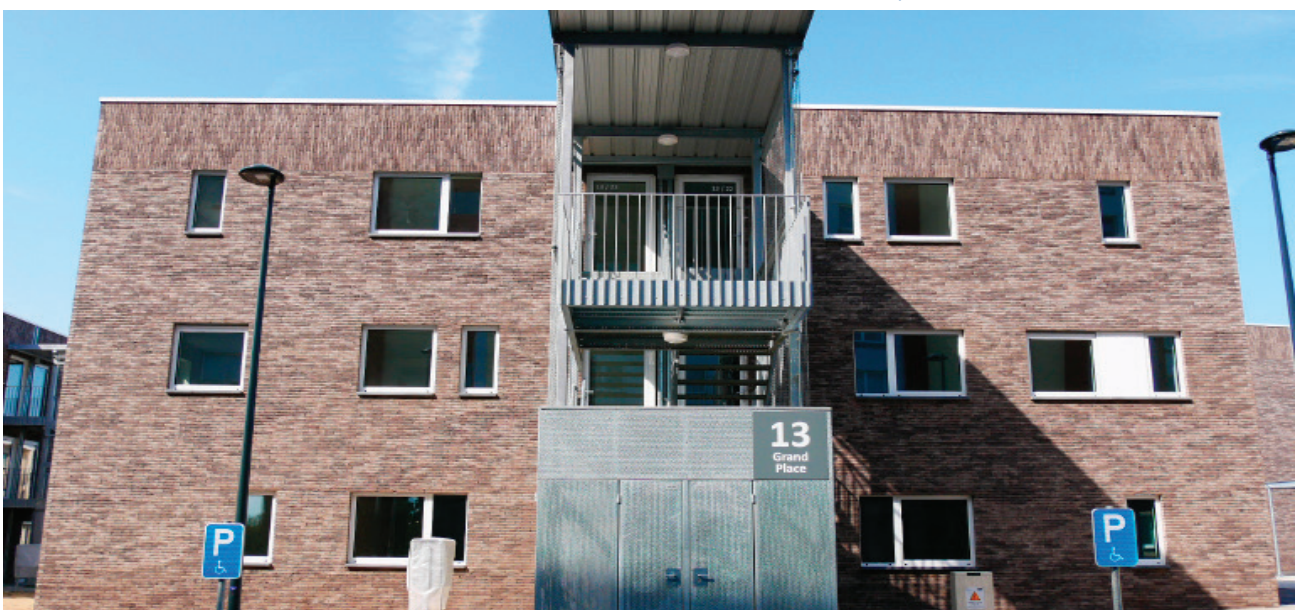
Außenliegender Treppenaufgang mit externem Technikraum und Platz Raum für Müllcontainer (Foto: pmp)
