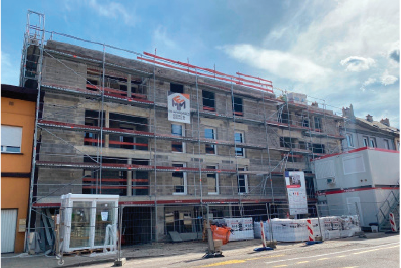
Laufende Arbeiten, April 2021 (Foto: Vivest)
