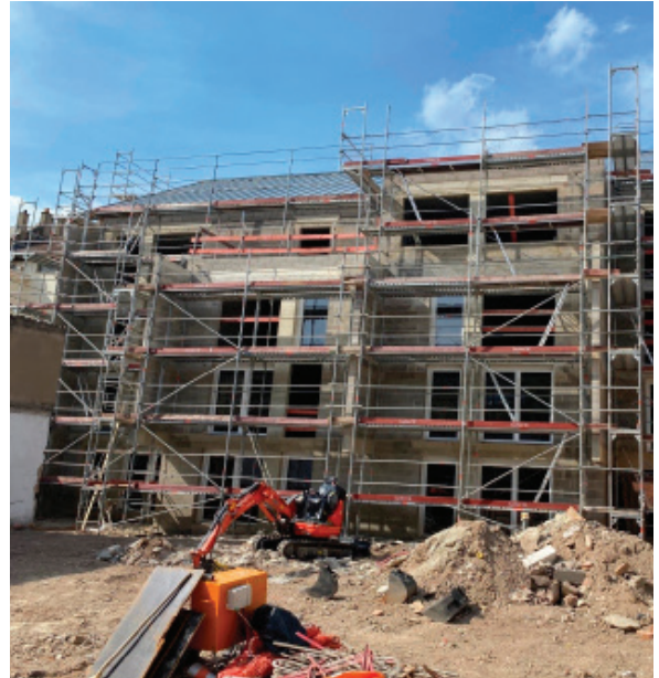
Laufende Arbeiten, April 2021 (Foto: Vivest)
