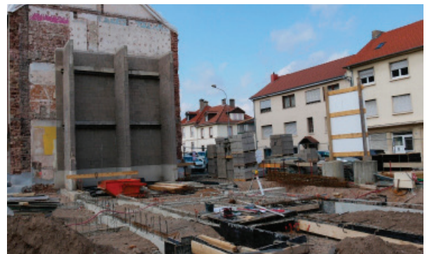
Die Baustelle im September 2020 (Foto: ARGE SOLAR)
