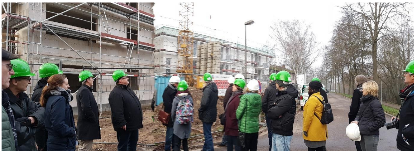
Baustellenbegehung am 12.12.2018 in Saarlouis Husarenweg 12/12a / Visite de chantier «Husarenweg 12/12a» le 12/12/2018 à Saarelouis (Foto/Photo: ARGE SOLAR)
