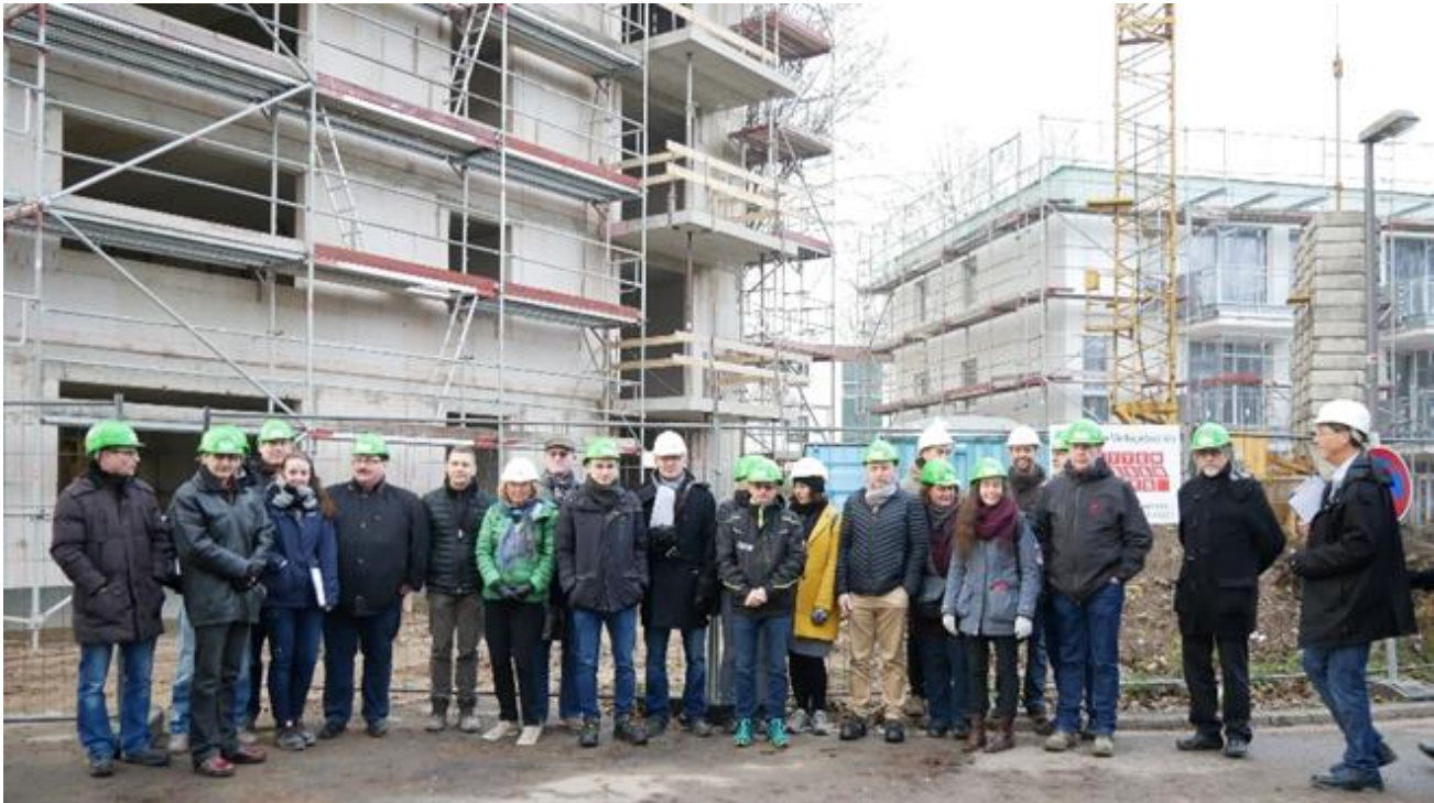
GReENEFF-Baustellenbegehung im Dezember 2018. Visite de chantier GReENEFF en décembre 2018, © ARGE SOLAR
