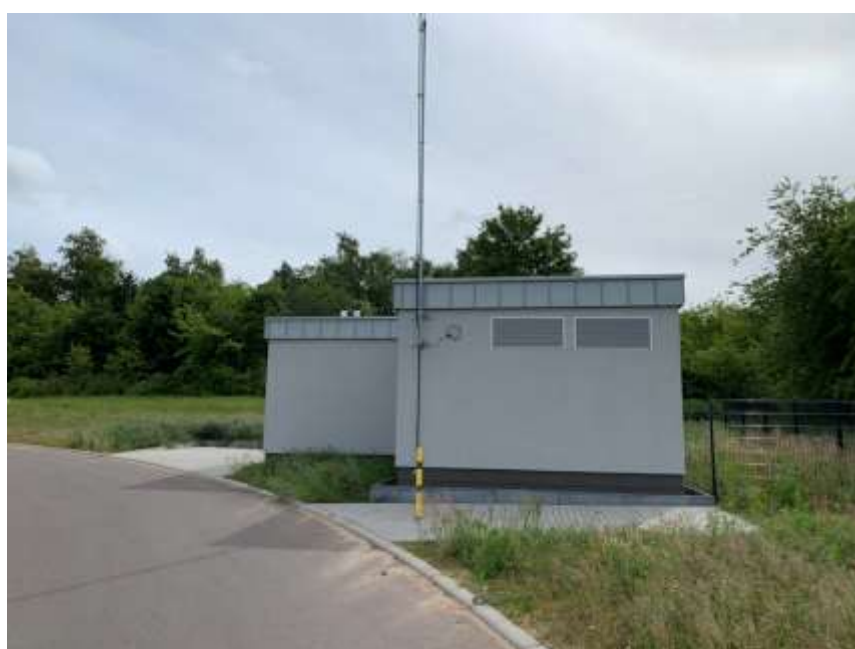
Vue avant de la sous-station de chauffage local
