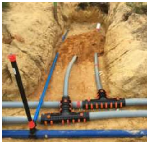
Niveau de pose inférieur avec conduite d'eau potable (bleu) et tube de départ/retour de chauffage local, fabricant Rehau © GWBS
