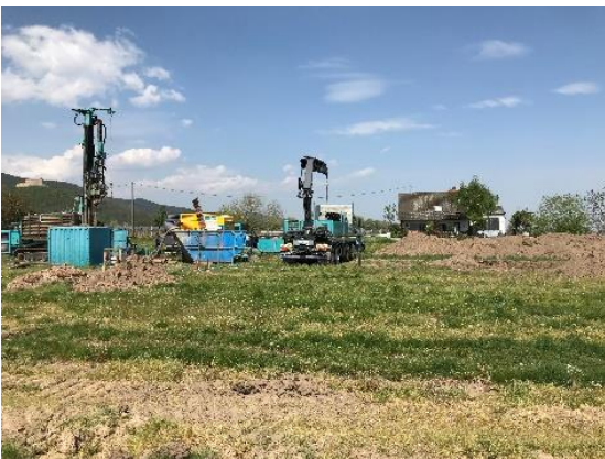
Herstellung der Pilotsonde (Foto: Pfalzwerke)
