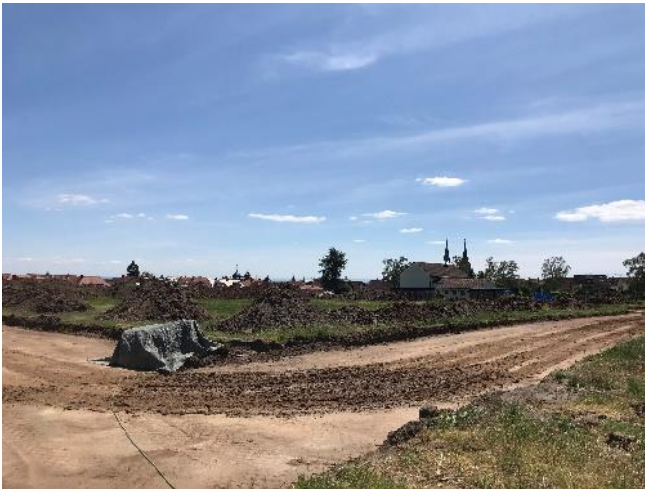
Der Geothermal-Response-Test läuft über eine Dauer von bis 72 Stunden – hier ist die Anlage unter dem Wetterschutz zu sehen. (Foto: Pfalzwerke)
