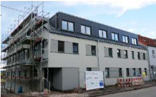
Neubau Herrenstraße 33-37, Saarlouis, Saarland, Schwerpunkt: Barrierefreies Bauen
