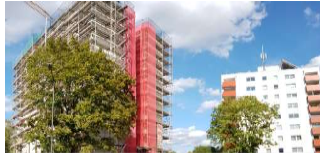
Renovierung Fasanenallee 4 + 6, Saarlouis, Saarland, Schwerpunkt: Energieeffiziente Sanierung
