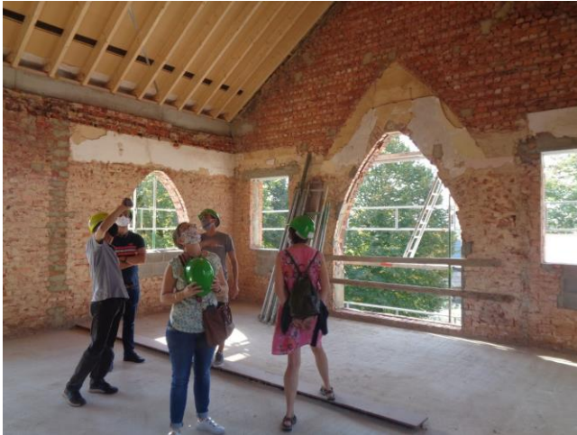
Citénergie Aubel, Foto/photo : ARGE SOLAR
