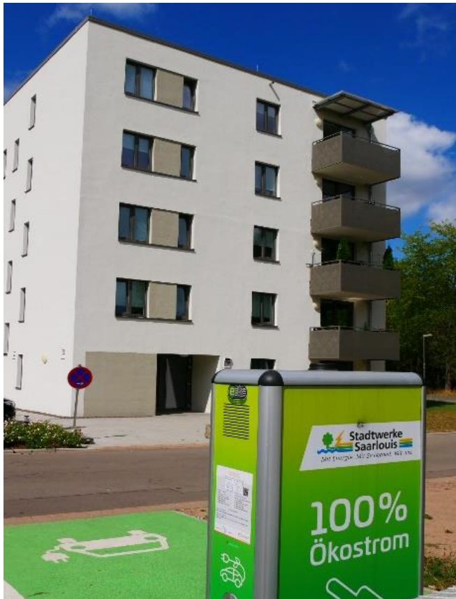
Neubau Husarenweg 12 a nach der Fertigstellung. Im Vordergrund die neue Ladestation für Elektroautos der Stadtwerke Saarlouis (Foto: ARGE SOLAR)
