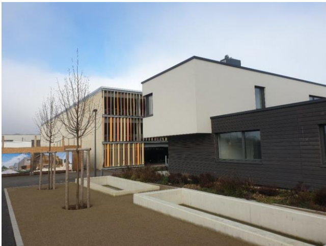
Elmen: Im Vordergrund eines der Muster-Einfamilienhäuser. Dahinter das fertiggestellte erste Parkhaus des Quartiers. Der individuelle Kfz-Verkehr ist auf die Zufahrten zu den insgesamt drei Parkhäusern beschränkt. Zusätzliche Parkmöglichkeiten bei den Häusern und Wohnungen gibt es keine. Foto: ARGE SOLAR
