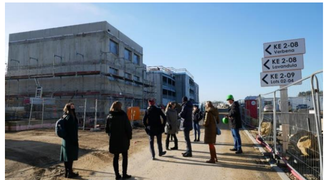
Visite du chantier à « Elmen » le 13/01/2022 : le nouveau quartier en cours de construction séduit par sa taille – même si l'on ne voit jusqu'à présent que la première tranche de construction. Photo : ARGE SOLAR
