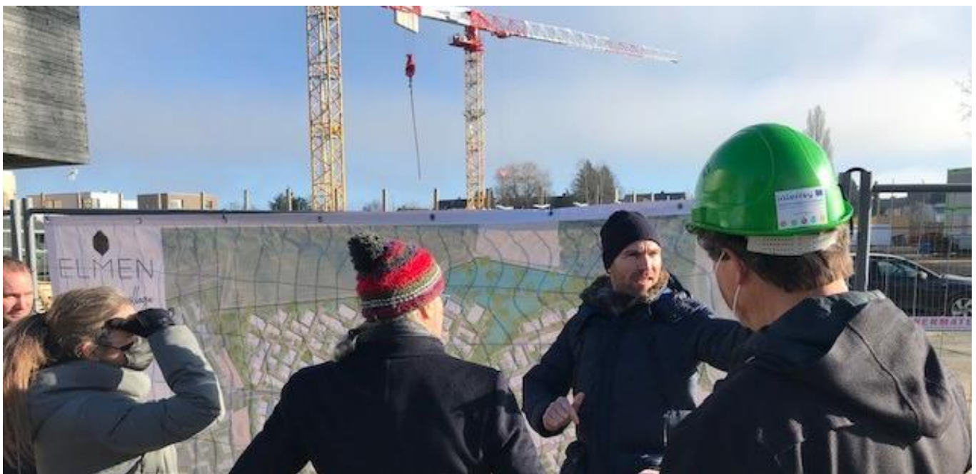
Inspirierender Ort für die Abschlussveranstaltung am 12. Mai: Die Baustelle in ELMEN. (Foto: myenergy) Un lieu inspirant pour la manifestation de clôture du 12 mai : le chantier d'ELMEN. (Photo : myenergy)
