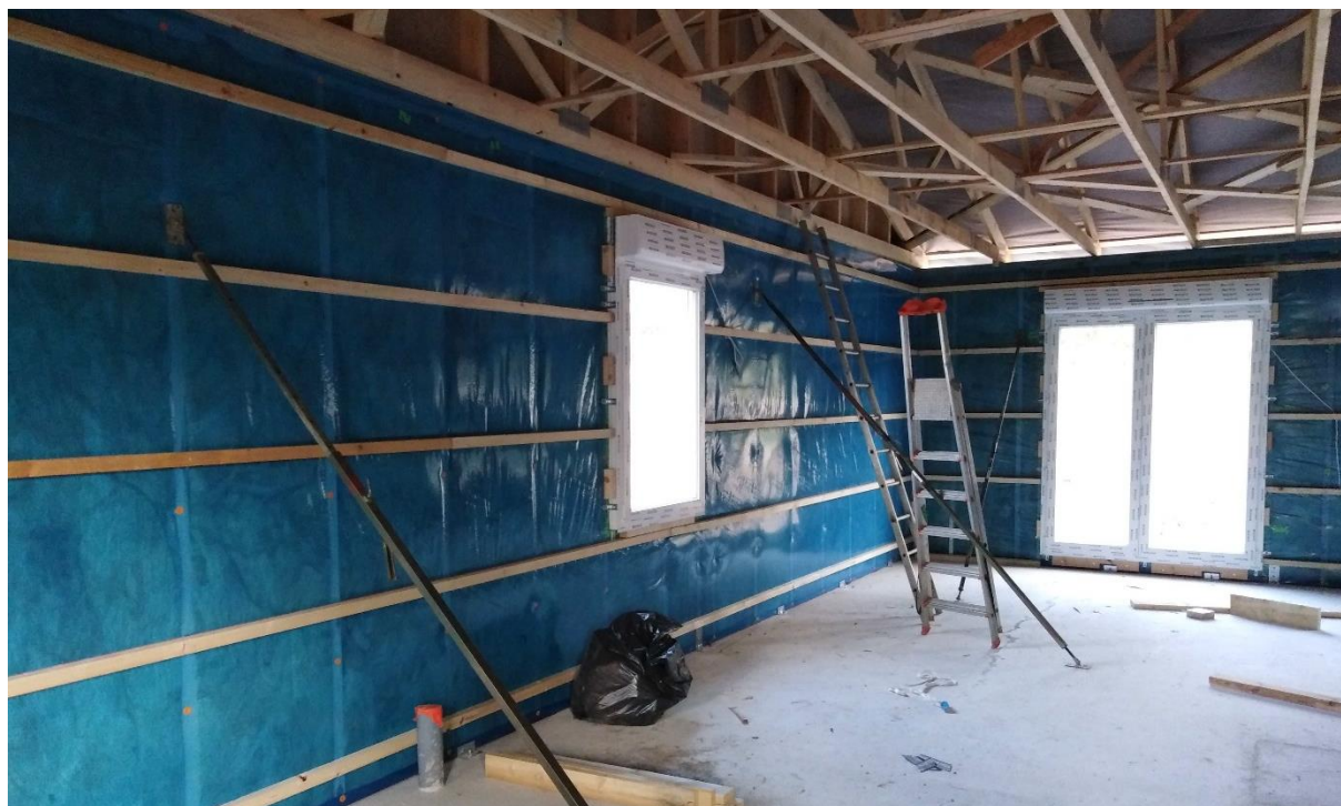
Démarrage de la phase de réalisation des pavillons (Photo: MOSELIS / CDC Ste Barbe)
