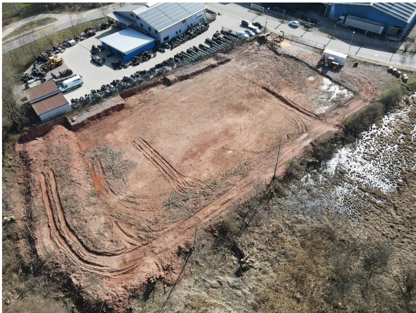
Figure 3: chantier du centre forestier d'Annweiler lors des travaux de terrassement (photo : Trifels Natur GmbH)
