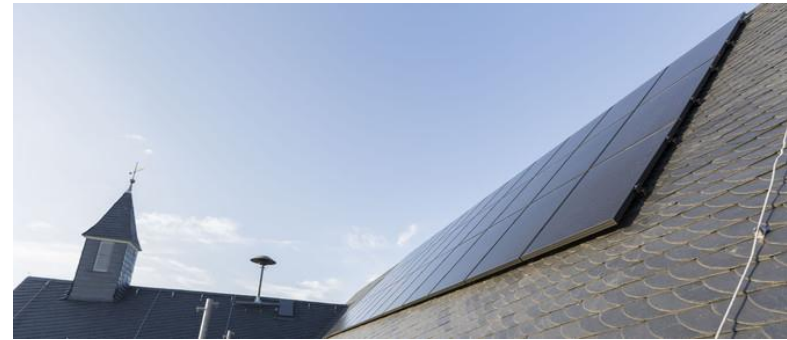
Foto/photo: Energieagentur Rheinland-Pfalz
