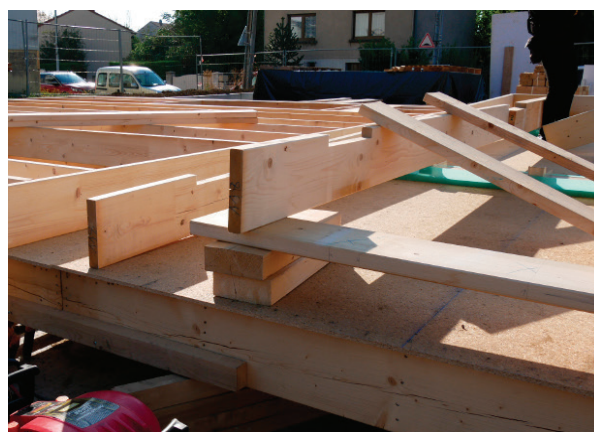
Le chantier de construction en septembre 2020. Les éléments en bois sont assemblés sur place. L'atelier du charpentier est situé sur le site de construction. (Photos: ARGE SOLAR)
