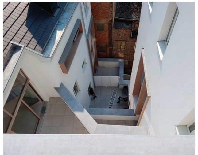
Des situations de vie modernes avec des vues intéressantes sont créées dans l'ancien bâtiment. La majorité des logements disposent d'espaces extérieurs privatifs (terrasses). (Photos : ARGE SOLAR)
