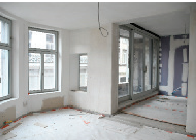
Intérieur (Photos: Jean-Pierre Ers, Urbanisme, Ville de Liège)
